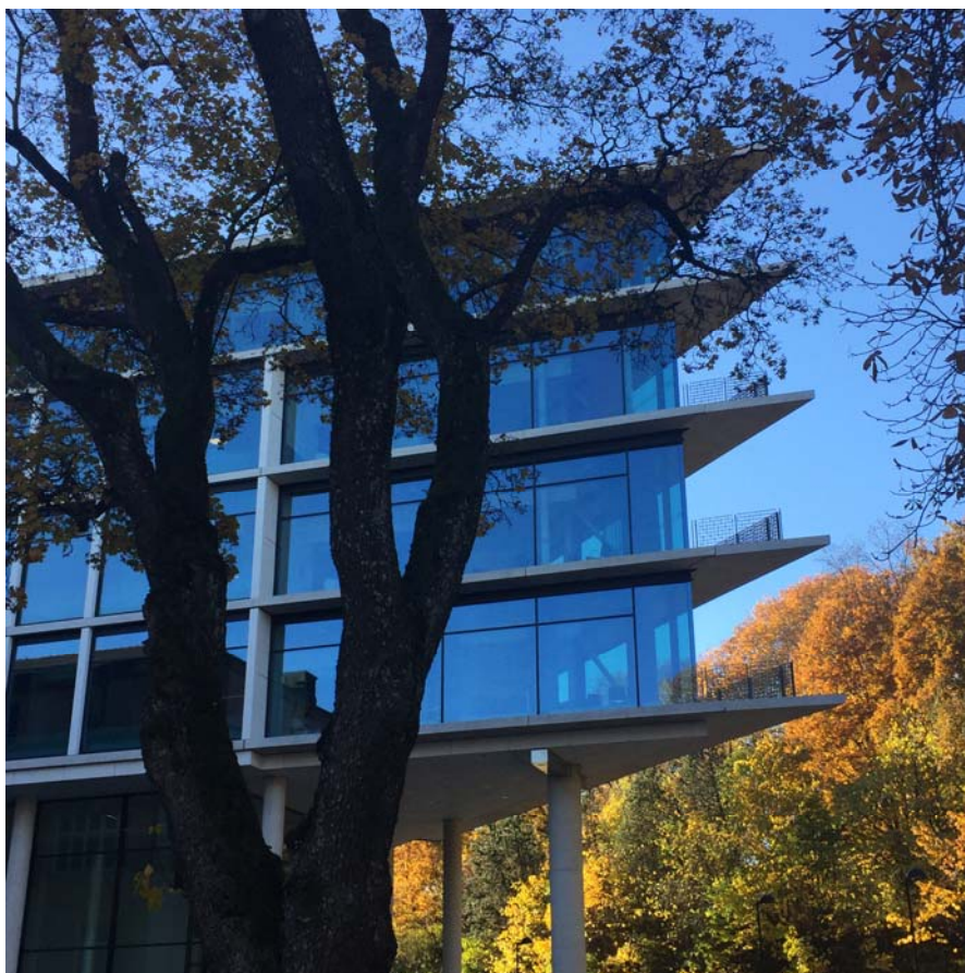
Psykiatrins hus, Landstinget i Uppsala län
